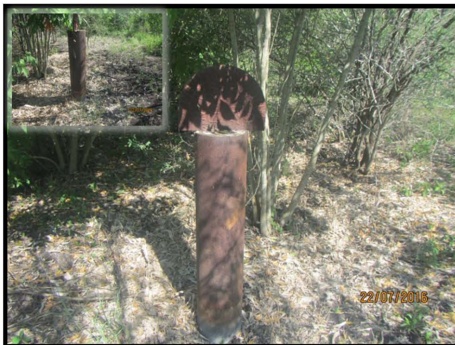
Fotografía 1.- El Pozo Barcodón 158 del Área Contractual Barcodón, fue taponado y su Línea de Recolección fue inertizada, por lo cual ya no cuenta con Derecho de Vía, localizado en las coordenadas UTM WGS84 X: 605221 Y: 2494791 .
