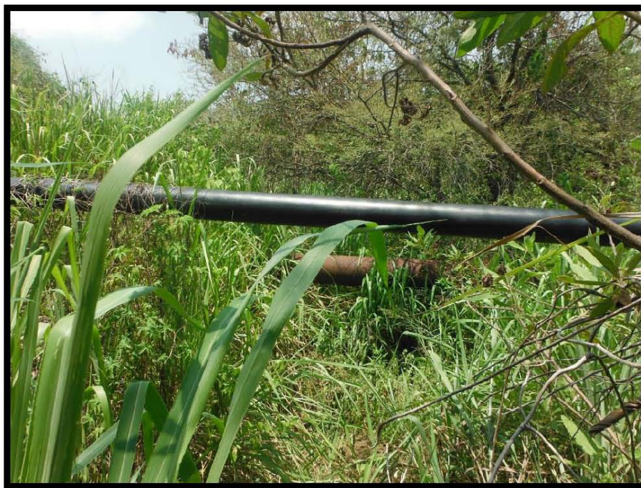
Fotografía 7.- Tubería expuesta sobre el Derecho de Vía, en las coordenadas UTMWGS84 X: 605928 Y: 2496537.
