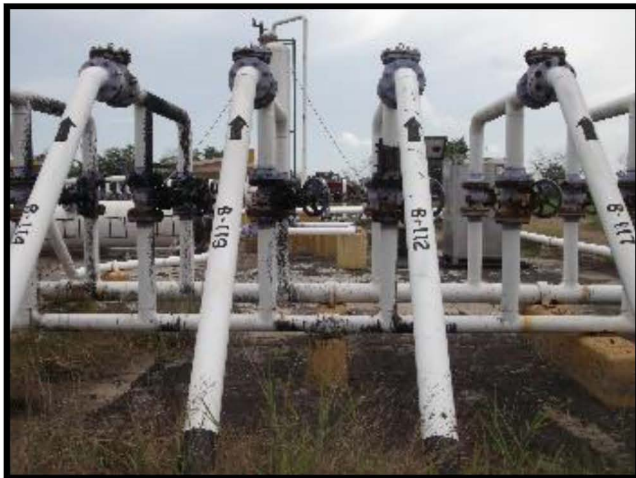
Fotografía 17.- Llegada al Colector de la Línea de Recolección del Pozo Barcodón 119 a la Batería de Separación Barcodón 1, en las coordenadas UTM WGS84 X:606088 Y: 2497150.
