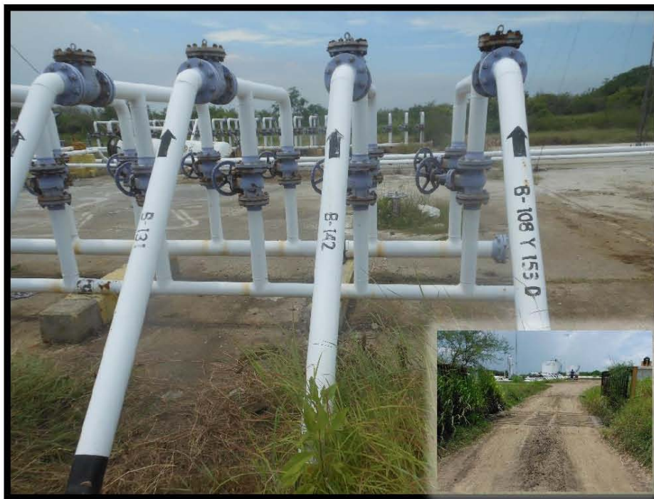
Fotografía 6.- Llegada al Colector de la Línea de Recolección del Pozo Barcodón 108 a la Batería de Separación Barcodón 1, en las coordenadas UTM WGS84 X: 606088 Y: 2497150.
