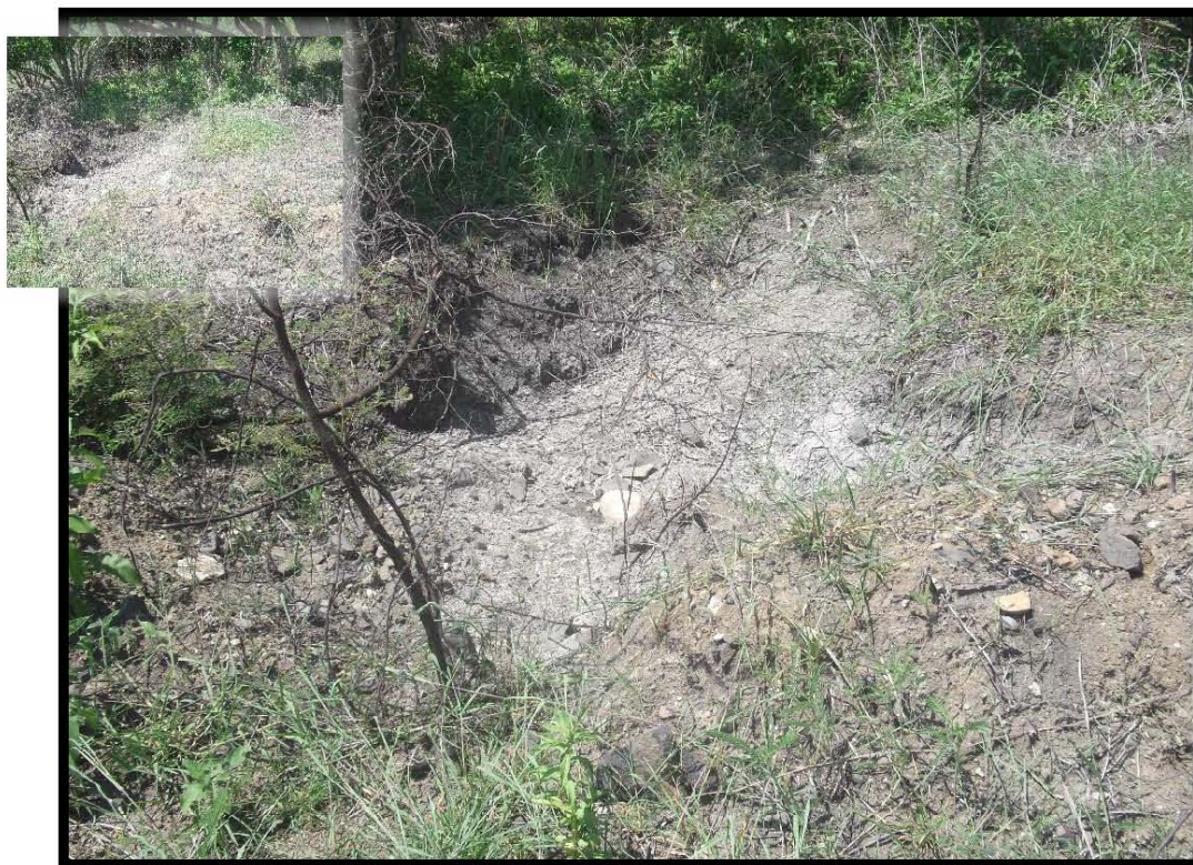
Fotografía 4.- Hundimiento sobre Derecho de Vía del Pozo Barcodón 119, en las coordenadas UTM WGS84 X: 605651 Y: 2497794.
