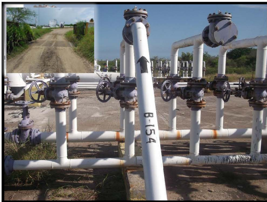
Fotografía 7.- Llegada de Línea de Recolección del Pozo Barcodón 154 a Cabezal de Recolección de Batería de Separación Barcodón 1, en las coordenadas UTM WGS84 X: 606092 Y: 2497125.
