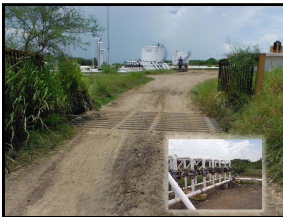
Fotografía 15.- No se localizó llegada de Línea de Recolección del Pozo Barcodón 162 a Cabezal de Recolección de la Batería de Separación Barcodón 1, en las coordenadas UTM WGS84 X: 606070 Y: 2497155.
