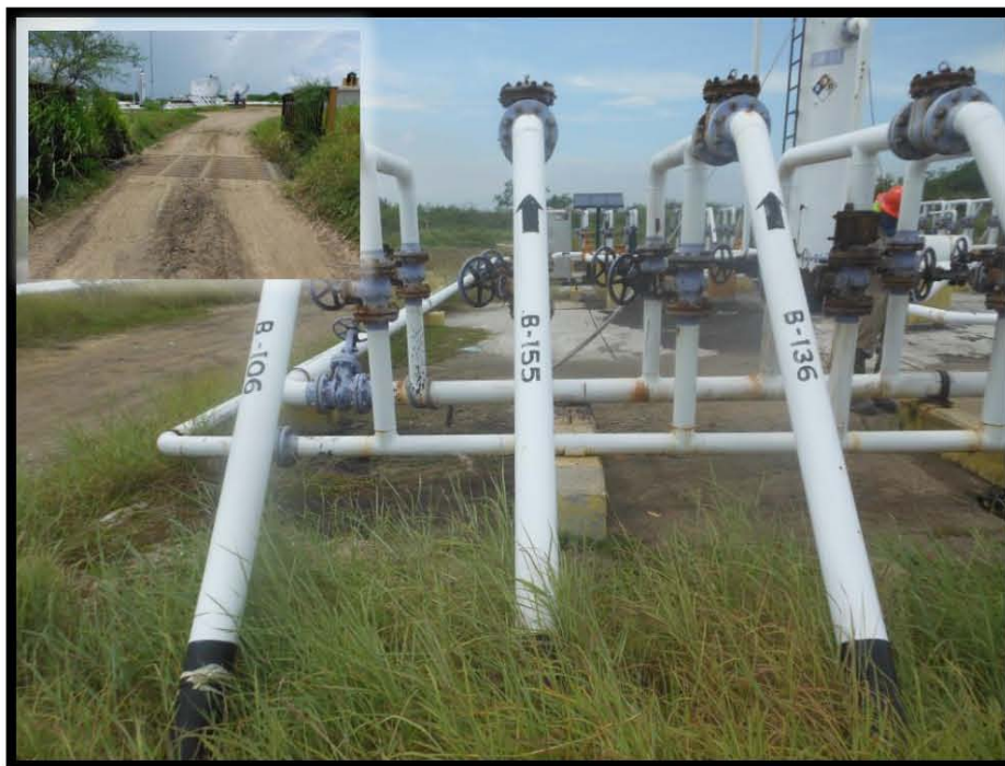
Fotografía 8.- Llegada de Línea de Recolección del Pozo Barcodón 136 a colectores de la Batería de Separación Barcodón 1, en las coordenadas UTM WGS84 X: 606088 Y: 2497150.
