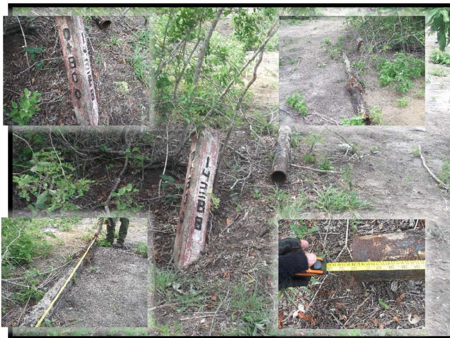
Fotografía 8.- Poste Tipo R 134 km 0+800, con Tubería Abandonada de 4" 3.30m. con grapa de Derecho de Vía del Pozo Barcodón 121, en las coordenadas UTM WGS84 X: 606145 Y: 2497442.
