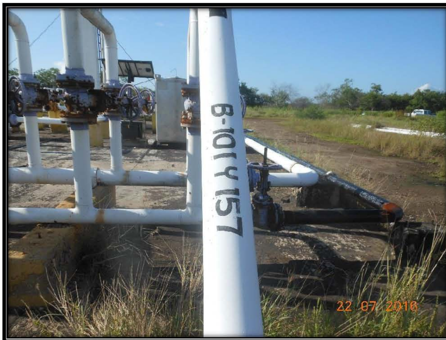
Figura 9.- Llegada de Línea de Recolección compartida de los pozos Barco 101 y Barcodón 157 a Cabezal de Colectores de Batería de Separación Barcodón 1, en las coordenadas UTM WGS84 X: 606070 Y: 2497158.
