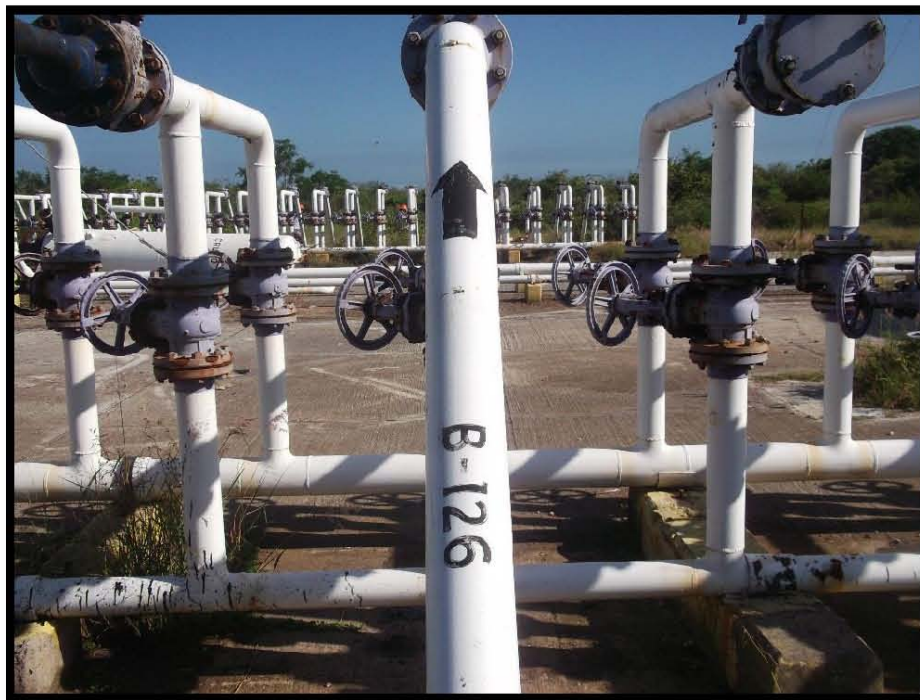
Fotografía 9.- Llegada de Línea de Recolección del Pozo Barcodón 126 a Cabezal de Colectores de Batería de Separación Barcodón 1, en las coordenadas UTM WGS84 X: 606094 Y: 2497146.
