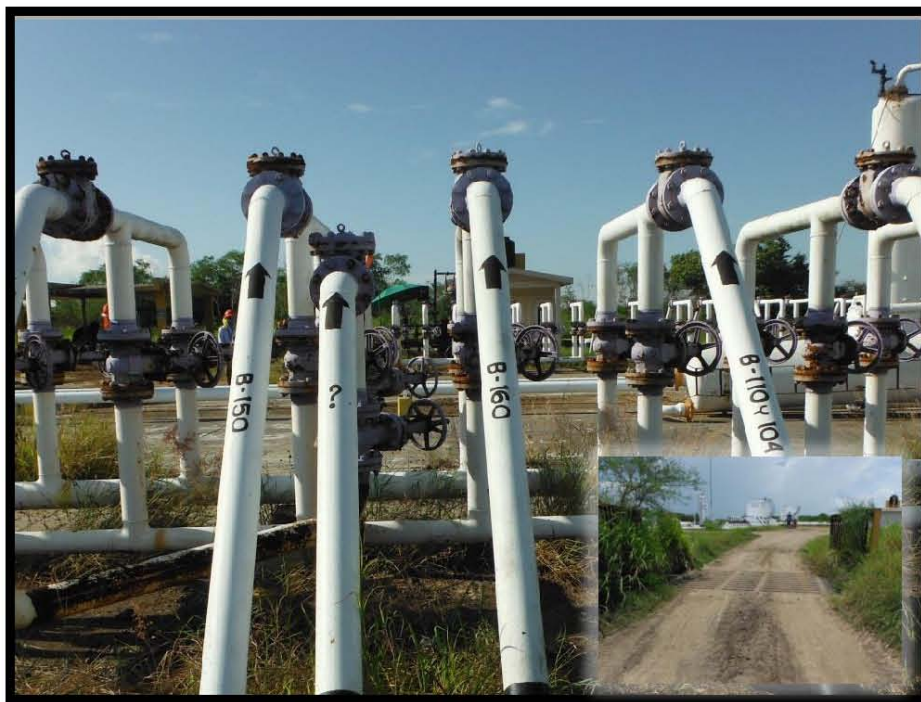
Fotografía 14.- Llegada de Línea de Recolección del pozo Barcodón 160 al Cabezal de Recolección de Batería de Separación Barcodón 1, en las coordenadas UTM WGS84 X: 606076 Y: 2497161.
