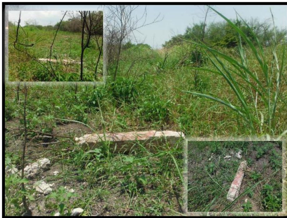
Fotografía 9.- Poste tipo Catódico dañado sin datos de Línea De Recolección en las coordenadas UTM WGS84 X: 605930 Y: 2496986.
