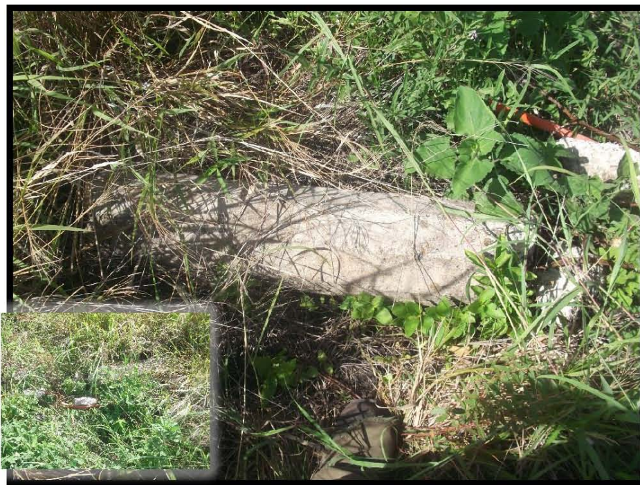
Fotografía 3.- Poste tipo R dañado sobre Línea De Recolección del Pozo Barcodón 169, en las coordenadas UTM WGS84 X: 606594 Y:2495885.
