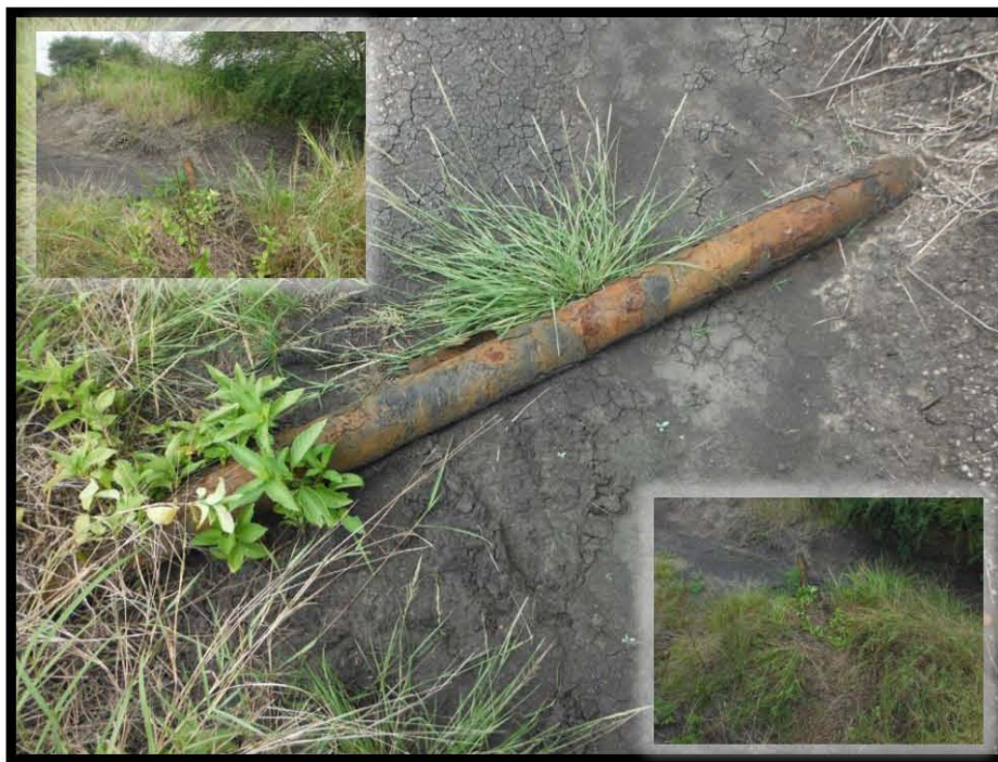
Fotografía 3.- Tubería expuesta en escorrentía intermitente sobre el derecho de Vía del Pozo Barcodón 147, en las coordenadas UTM WGS84 X: 607095 Y:2497187.
