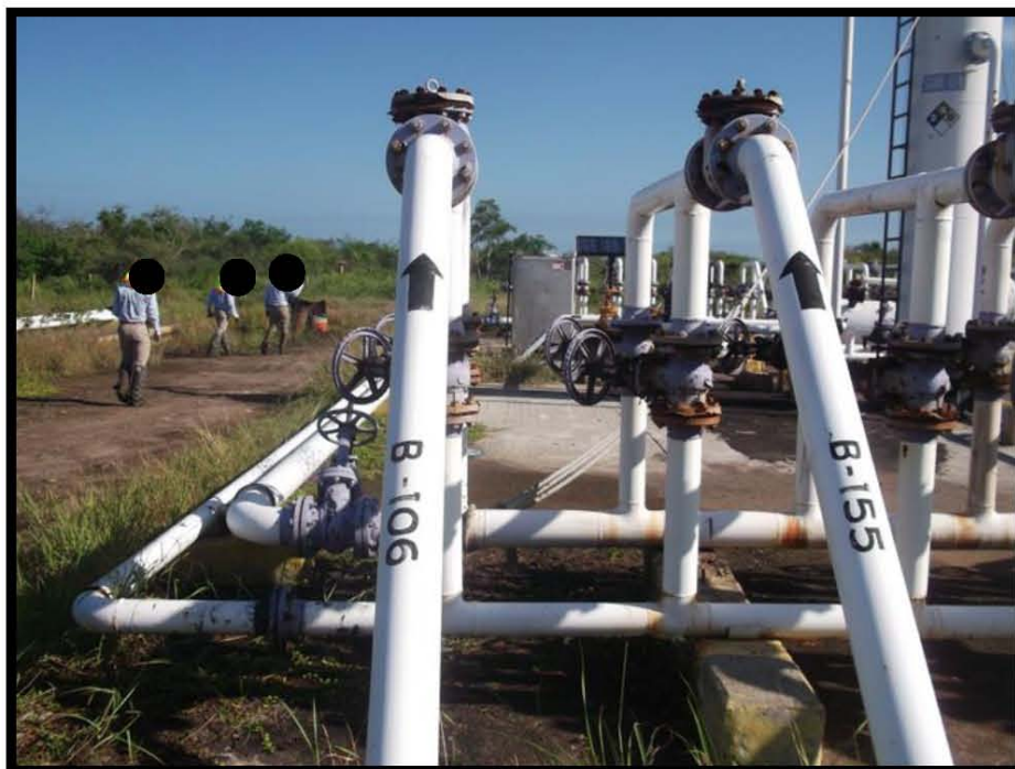
Fotografía 6.- Llegada de Línea de Recolección del Pozo Barcodón 106 a Cabezal de Colectores de Batería de Separación Barcodón 1, en las coordenadas UTM WGS84 X: 606080 Y: 2497138.
