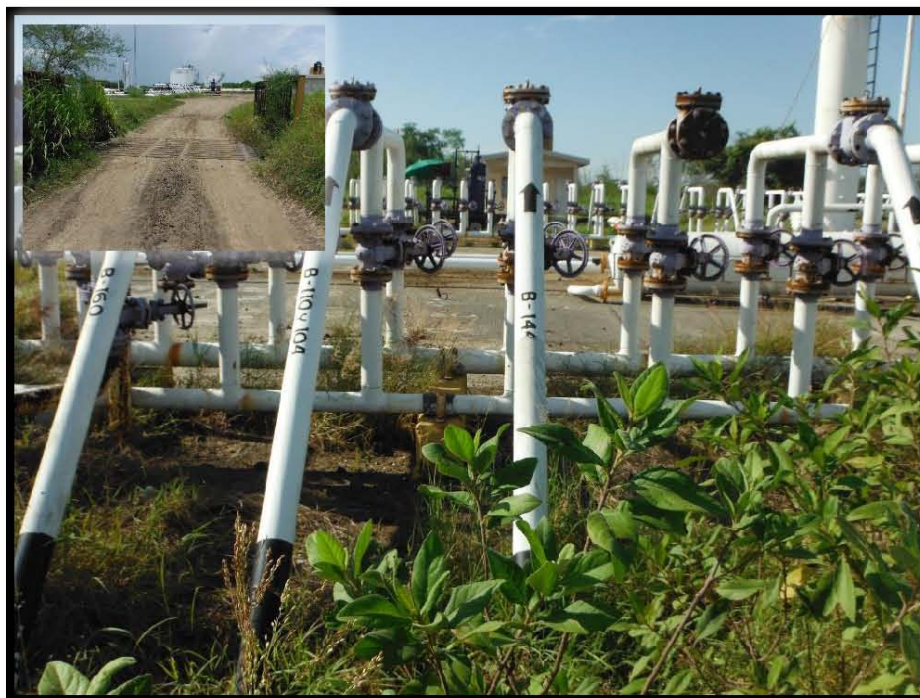
Fotografía 8.- Llegada de Línea de Recolección del Pozo Barcodón 104 a Cabezal de Colectores de Batería de Separación Barcodón 1. En las coordenadas UTM WGS84 X: 606080 Y: 2497138.
