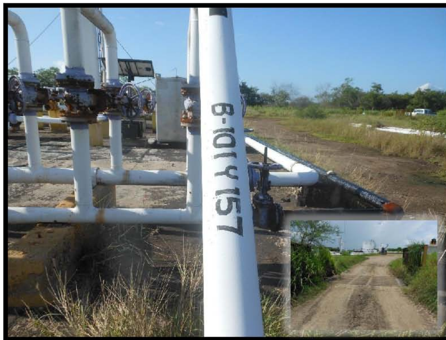
Fotografía 6.- Llegada de Línea de Recolección compartida de los pozos Barcodón 101 y Barcodón 157 a Cabezal de Recolección de Batería de Separación Barcodón 1, en las coordenadas UTM WGS84 X: 606072 Y: 2497164.
