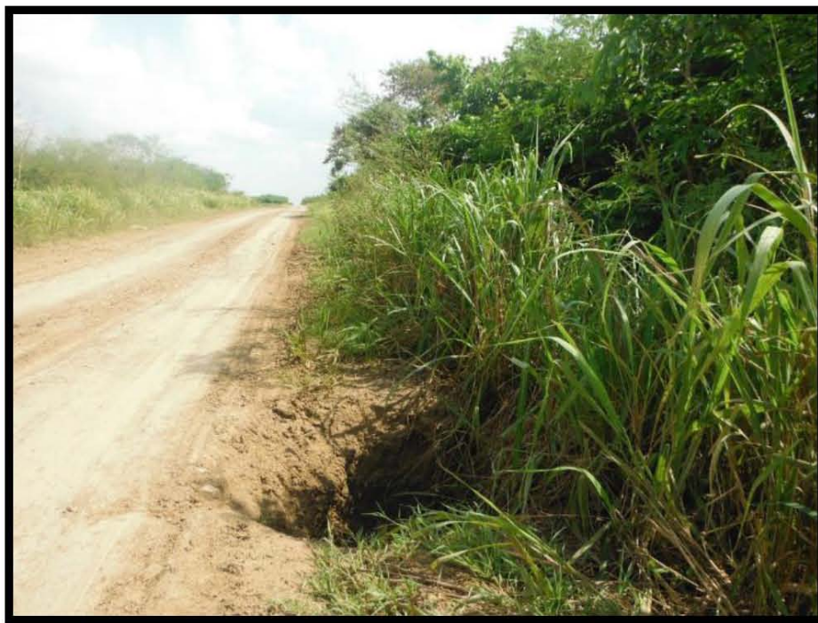
Fotografía 4.- Hundimiento sobre Línea De Recolección del Pozo Barcodón 165, en las coordenadas UTM WGS84 X: 605990 Y: 2495321.
