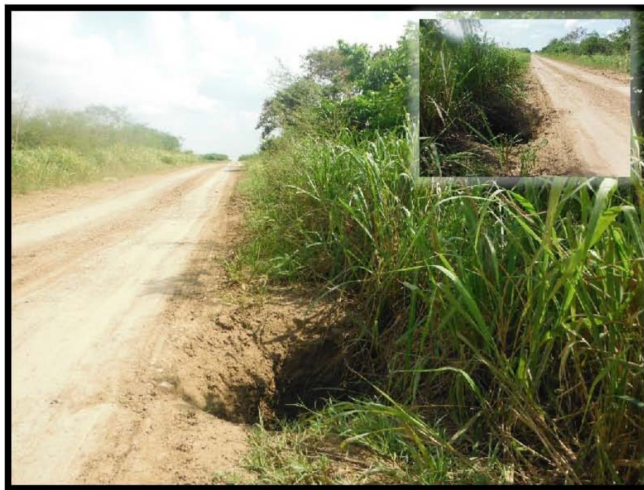
Fotografía 3.- Hundimiento sobre Derecho de Vía, en las coordenadas UTM WGS84 X: 605988 Y: 2495307.
