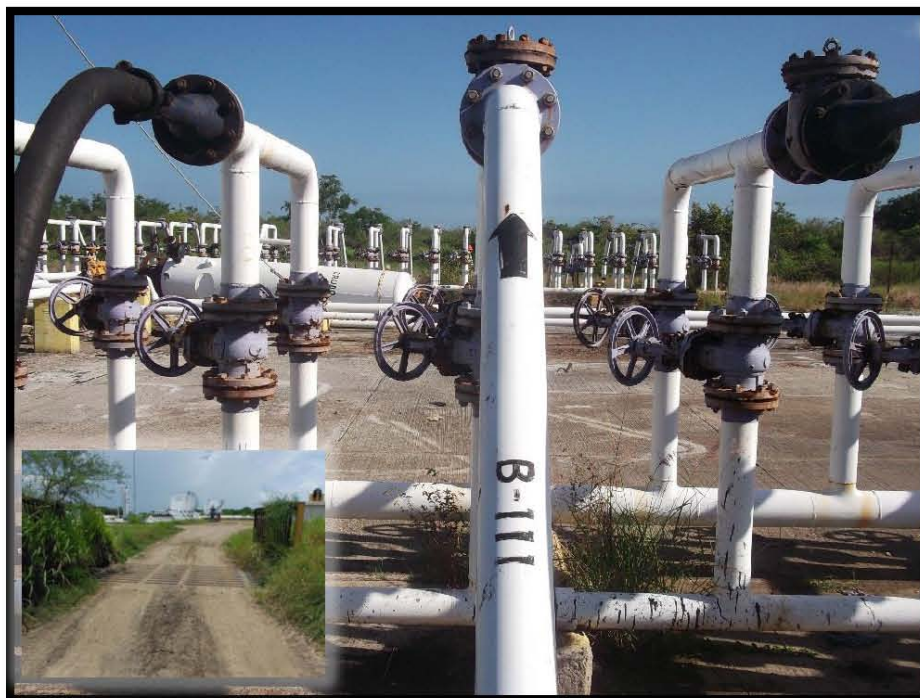
Fotografía 9.- Llegada de Línea de Recolección del Pozo Barcodón 111 a Cabezal Recolección de Batería de Separación Barcodón 1, en las coordenadas UTM WGS84 X: 606085 Y: 2497143.
