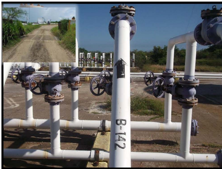
Fotografía 9.- Llegada de Línea de Recolección del Pozo Barcodón 142D a Cabezal de Colector de Batería de Separación Barcodón 1, falta rotulación de letra "D" en tubería de llegada, en las coordenadas UTM WGS84 X: 606095 Y: 2497150.
