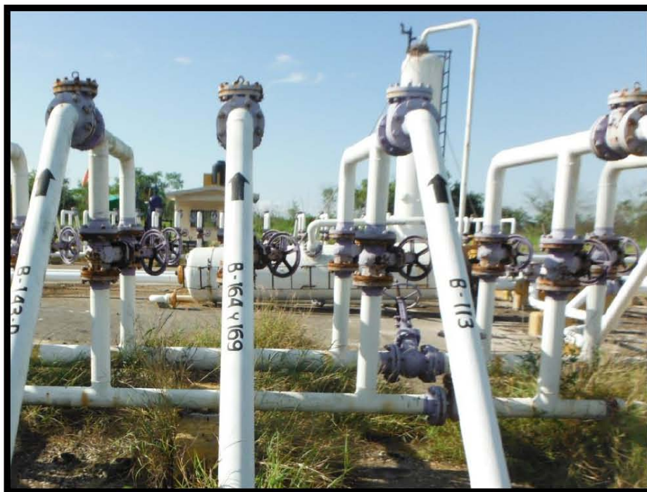
Fotografía 6.- Llegada de Línea de Recolección compartida de los Pozos Barcodón 164 y Barcodón 169 a Cabezal de Colectores de Batería de Separación Barcodón 1, en las coordenadas UTM WGS84 X: 606074 Y: 2497161.
