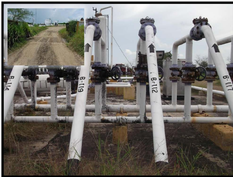
Fotografía 7.- Llegada al Colector de la Línea de Recolección del Pozo Barcodón 112 a la Batería de Separación Barcodón 1, en las coordenadas UTM WGS84 X: 606078 Y: 2497170.
