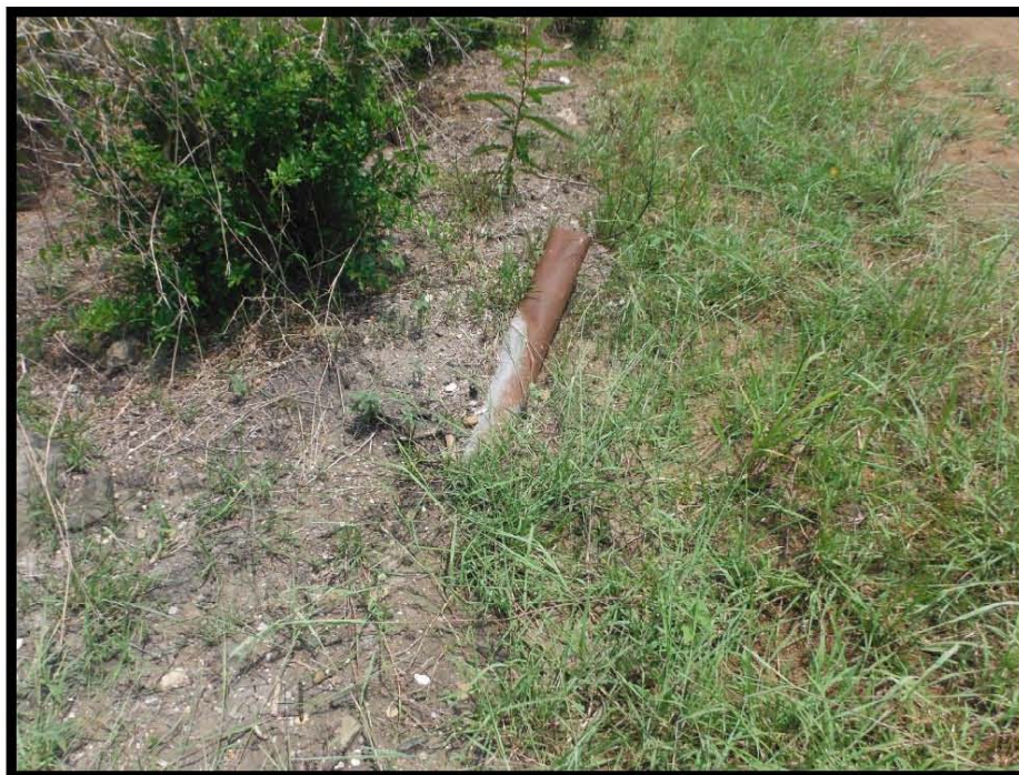
Fotografía 4.- Tubería expuesta sobre Línea De Recolección del Pozo Barcodón 163, en las coordenadas UTM WGS84 X: 605592 Y: 2498175.
