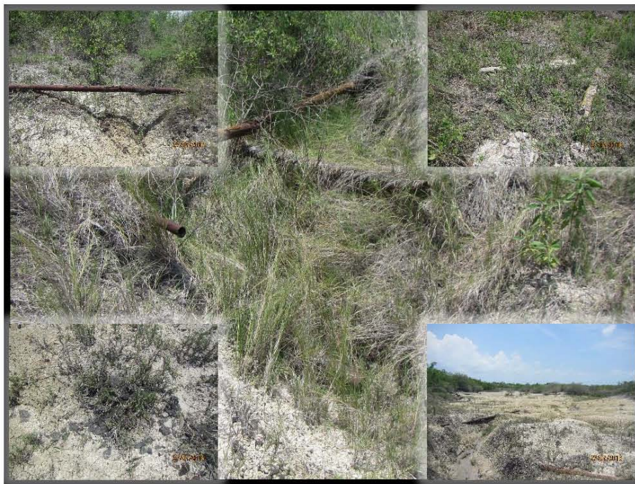
Fotografía 5.- Tubería expuesta, hidrocarburo intemperizado en escurrimiento temporal, poste catódico dañado, sobre Línea de Recolección del Pozo Barcodón 108, en las coordenadas UTM WGS84 X: 606184 Y: 2497246.
