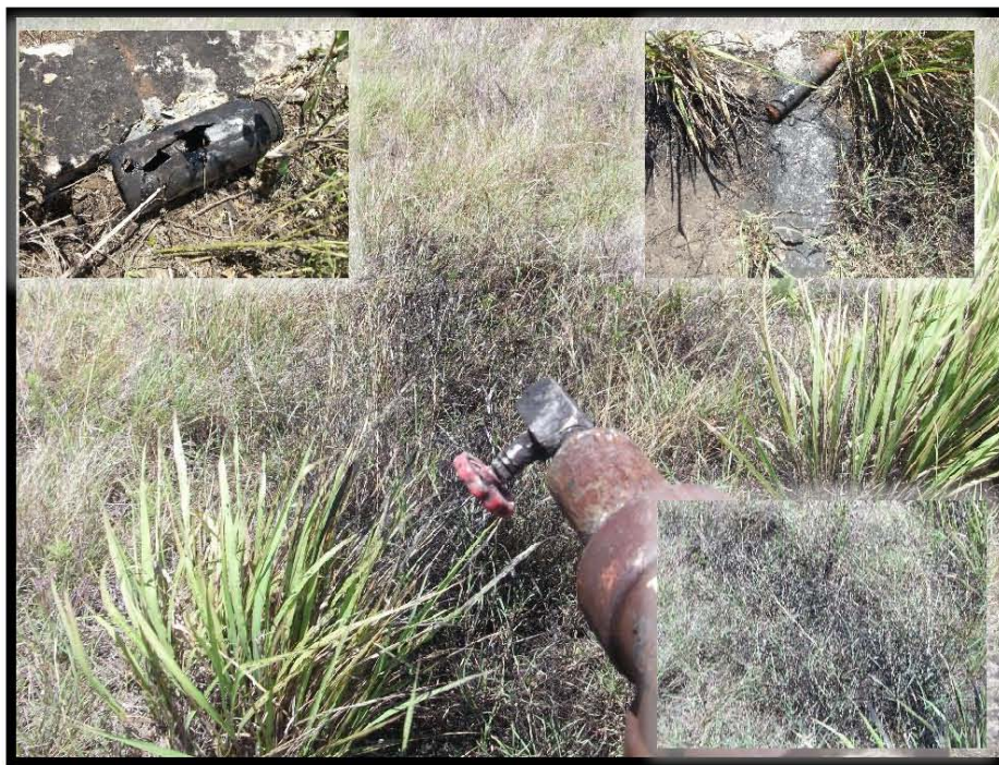
Fotografía 7.- Mancha de hidrocarburo a un costado del árbol de válvulas, residuos peligrosos en bajante de producción.
