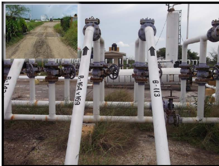
Fotografía 4.- Llegada de Línea de Recolección (compartida) del Pozo Barcodón 113 a colectores de la Batería de Separación Barcodón 1, en las coordenadas UTM WGS84 X: 606078 Y: 2497170.
