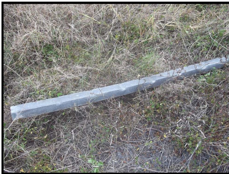
Fotografía 11.- Señalamiento del derecho de vía dañado del Pozo Barcodón 138 en las coordenadas UTM WGS84 X: 606732 Y: 2498465.
