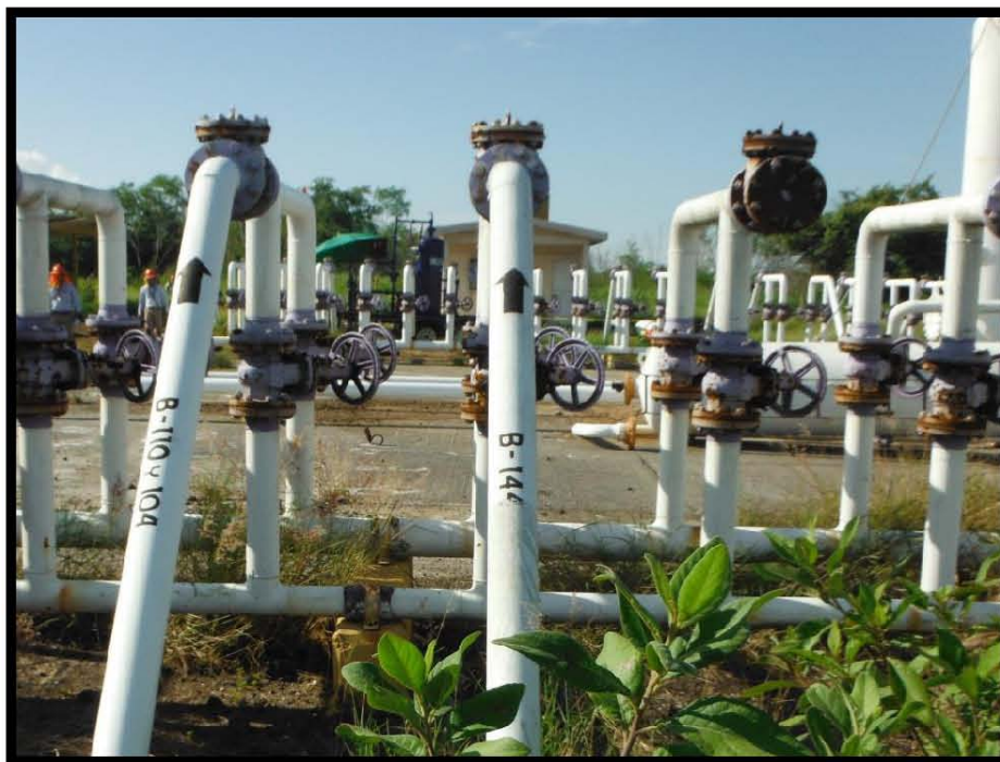
Fotografía 9.- Llegada de Línea de Recolección del pozo Barcodón 144 a Cabezal de Colectores de Batería de Separación Barcodón 1, en las coordenadas UTM WGS84 X: 606077 Y: 2497139.
