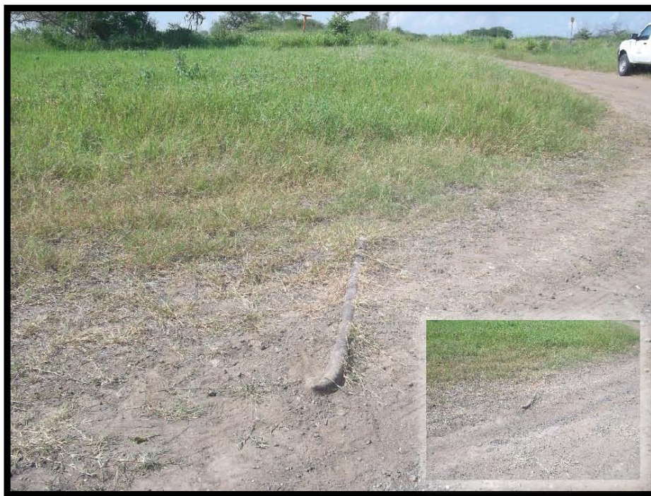
Fotografía 3.- Tubería expuesta de 1.9 metros de longitud sobre Derecho de Vía del Pozo Barcodón 159, en las coordenadas UTM WGS84 X: 606639 Y: 2498427.
