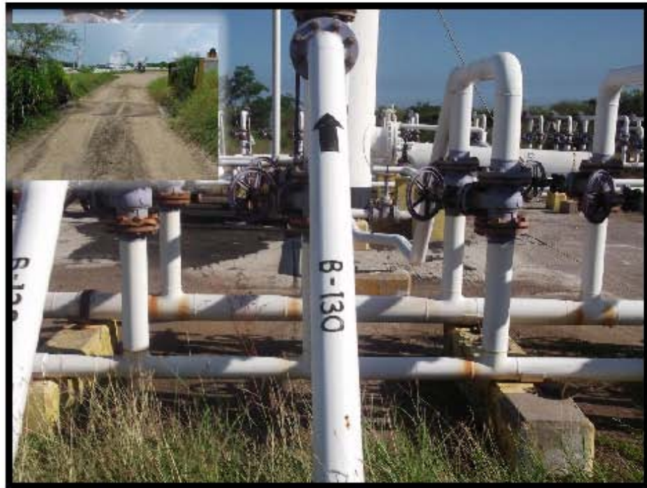
Figura 5.- Llegada de Línea de Recolección del Pozo Barcodón 130 a Cabezal de Recolección de Batería de Separación Barcodón 1, en las coordenadas UTMWGS84 X: 606086 Y: 2497144.
