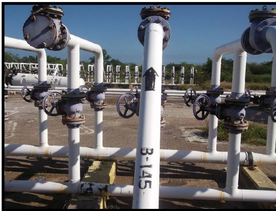
Fotografía 7.- Llegada de Línea de Recolección del pozo Barcodón 145 a Cabezal de Colectores de Batería de Separación Barcodón 1, en las coordenadas UTM WGS84 X: 606087 Y:2497130.
