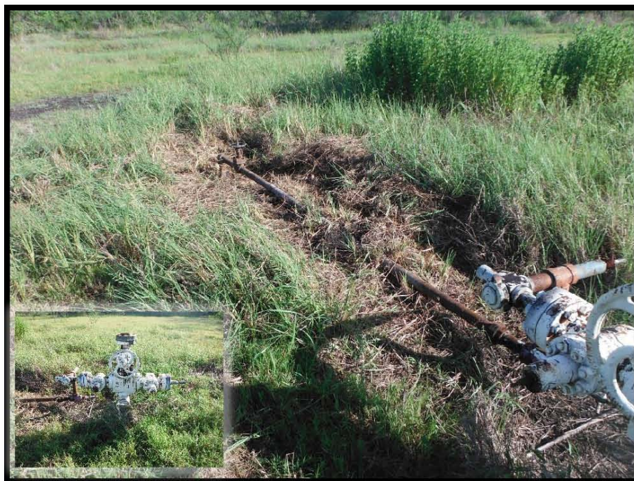
Fotografía 1.- Salida de Línea de Recolección del Pozo Barcodón 111 con destino a Bateria de Separación Barcodón 1, en las coordenadas UTMWGS84 X: 606347 Y: 2498572.
