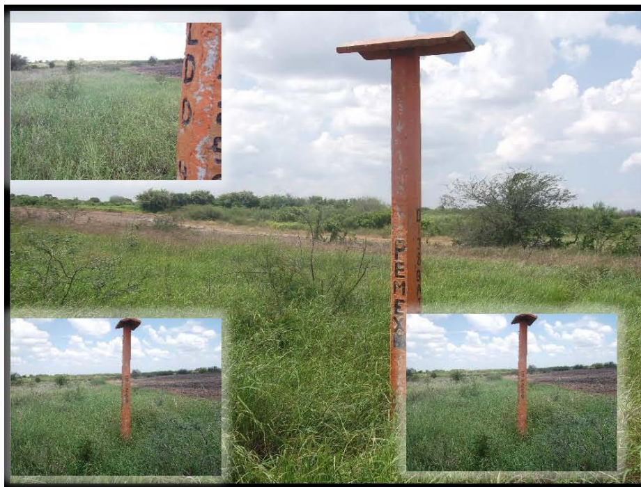
Fotografía 6.- Poste tipo 4 Km 0+250 Dañado del derecho de vía del Pozo Barcodón 138 en las coordenadas UTM WGS84 X: 607070 Y: 2498529.
