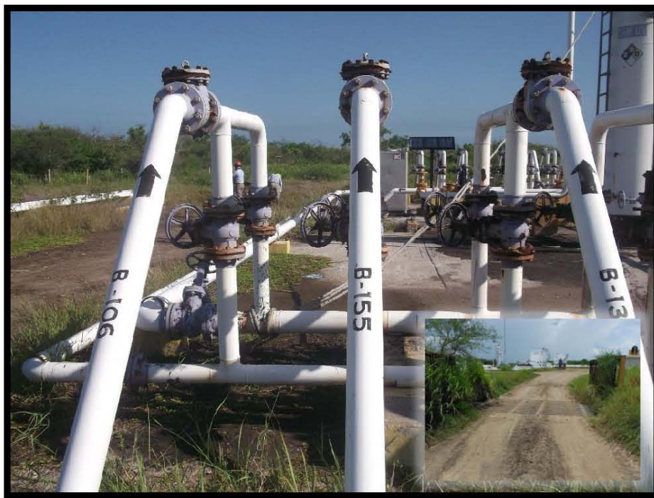
Fotografía 7.- Llegada de Línea de Recolección del pozo Barcodón 155 a Cabezal de Recolección de Batería de Separación Barcodón 1, en las coordenadas UTM WGS84 X: 606081 Y: 2497138.
