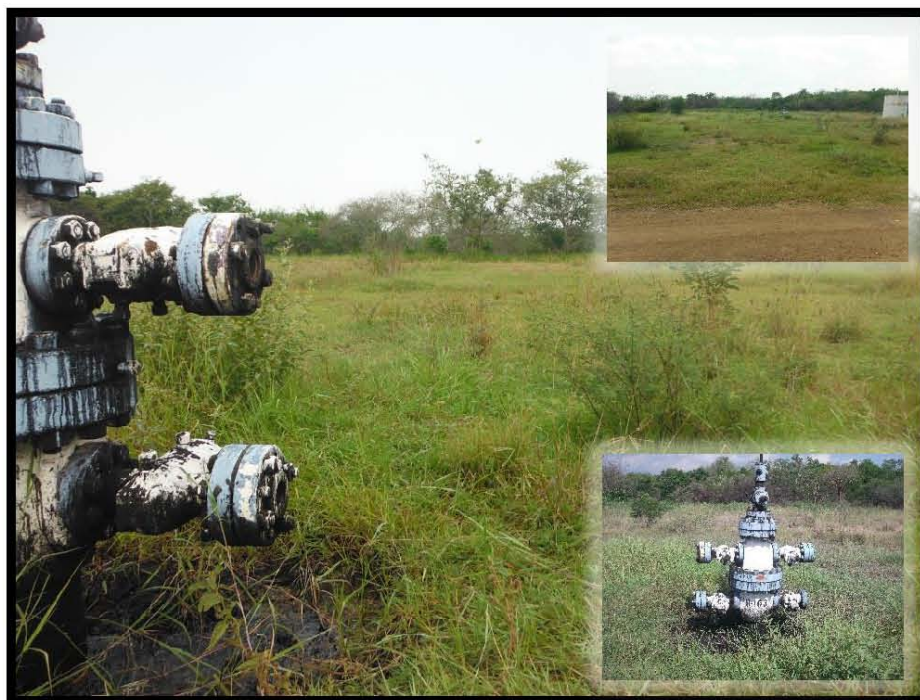
Fotografía 1.- Salida de Línea de Recolección del Pozo Barcodón 163 con destino a Batería de Separación Barcodón 1, en las coordenadas UTM WGS84 X: 605552 Y: 2498197.
