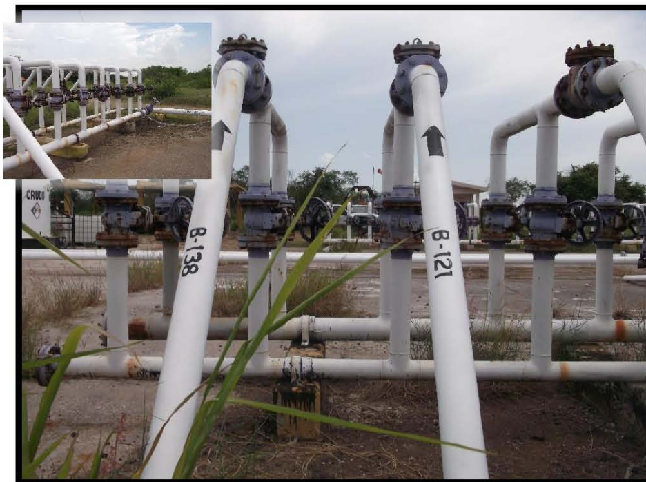
Fotografía 15.- Llegada al Colector de la Línea de Recolección del Pozo Barcodón 121 a la Batería de Separación Barcodón 1, en las coordenadas UTMWGS84 X: 606078 Y: 2497170.
