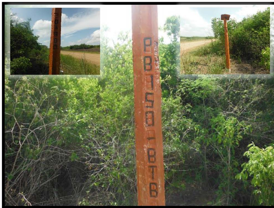
Fotografía 6.- Poste tipo R Barcodón 150, Kilometraje 0+750 con Línea de Descarga de 4", en las coordenadas UTM WGS84 X: 605991 Y: 2495493.
