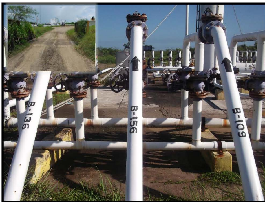
Fotografía 5.- Llegada de Línea de Recolección del pozo Barcodón 156 a Cabezal de Colectores de Batería de Separación Barcodón 1, en las coordenadas UTM WGS84 X: 606088 Y: 2497121.
