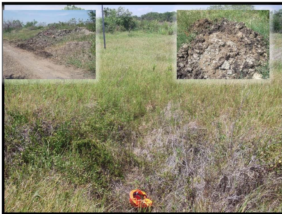
Fotografía 13.- Hundimiento de 5m x 8m con una profundidad 1.5m sobre derecho de vía del Pozo Barcodón 138 en las coordenadas UTM WGS84 X: 606700 Y: 2498395.
