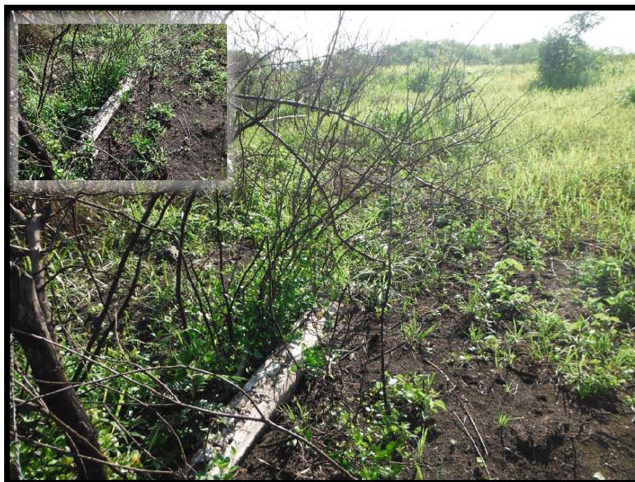
Fotografía 7.- Poste Catódico dañado sobre Derecho de Vía del Pozo Barcodón 111, en las coordenadas UTM WGS84 X: 606347 Y: 2498572.
