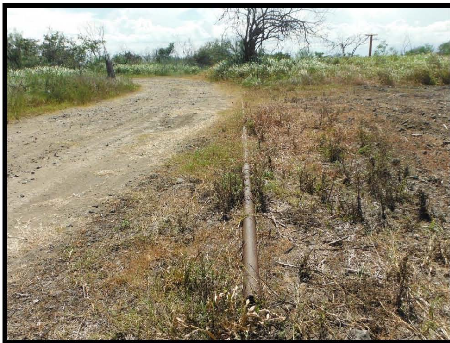
Fotografía 4.- Punto de inflexión hacia el Sur y tubería expuesta sobre el Derecho de Vía, en las coordenadas UTM WGS84 X: 606640 Y: 2497788.
