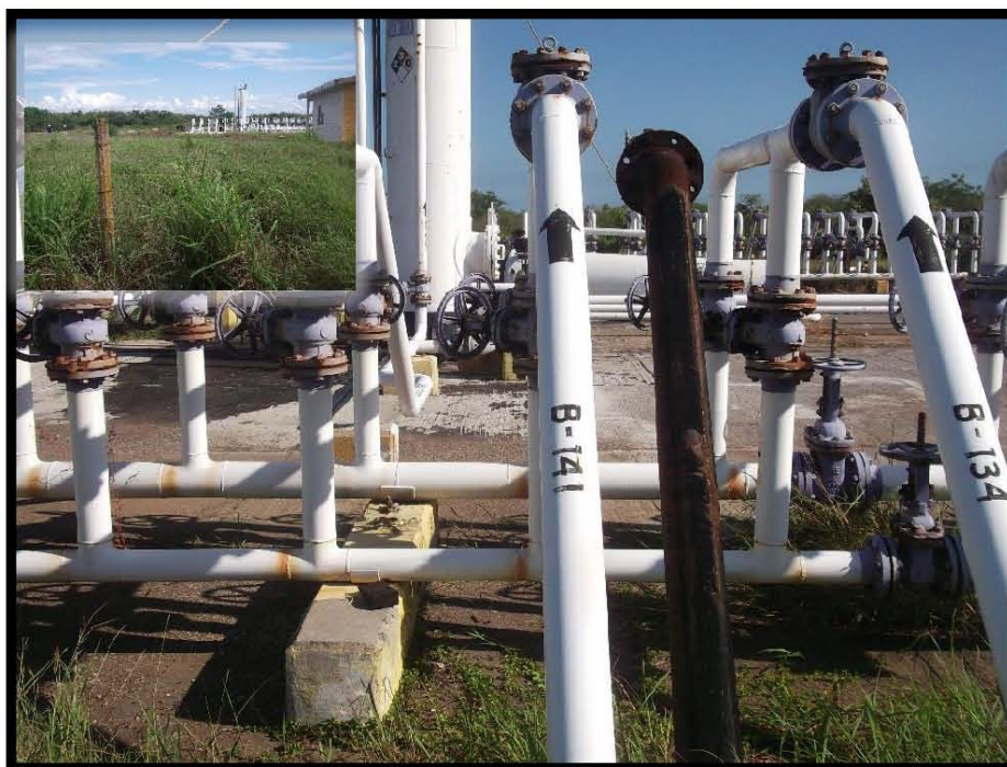
Fotografía 11.- Llegada de Línea de Recolección del Pozo Barcodón 141 a Cabezal de Colectores de Batería de Separación Barcodón 1, en las coordenadas UTM WGS84 X: 606085 Y: 2497136.
