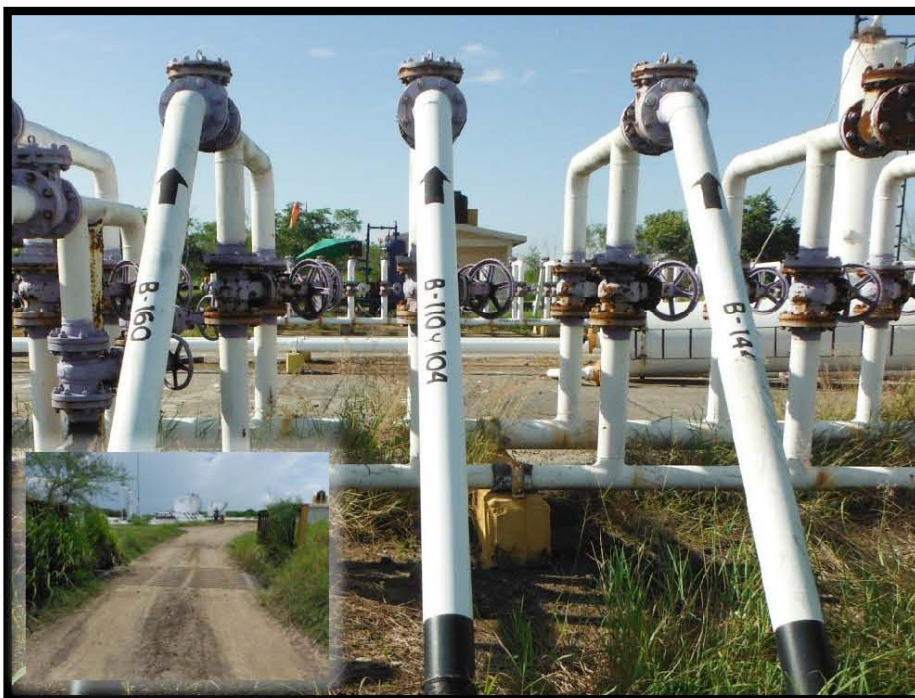
Fotografía 3.- Llegada de Línea de Recolección compartida de los Pozos Barcodón 110 y Barcodón 104 a Cabezal de Colectores de Batería de Separación Barcodón 1, en las coordenadas UTM WGS84 X: 606077 Y: 2497163.
