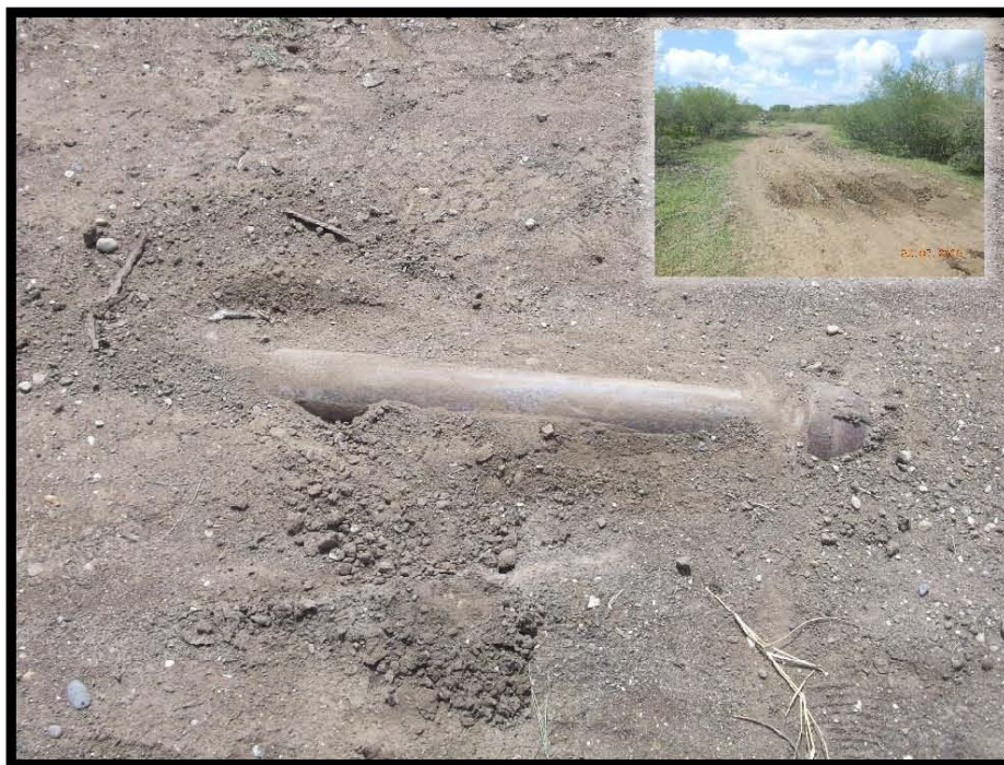
Fotografía 2.- Tubería expuesta sobre el Derecho de Vía del Pozo Barcodón 155, en las coordenadas UTM WGS84 X: 606258 Y: 2495805.
