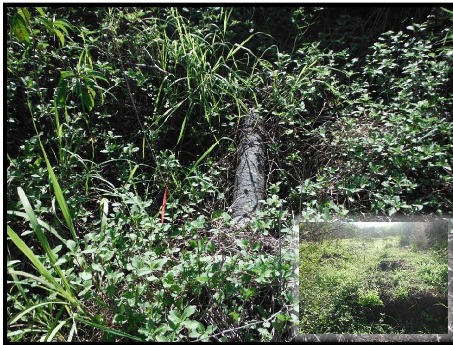
Fotografía 7.- Tubería expuesta en hundimiento sobre Derecho de Vía del Pozo Barcodón 126, en las coordenadas UTM WGS84 X: 605873 Y: 2496989.
