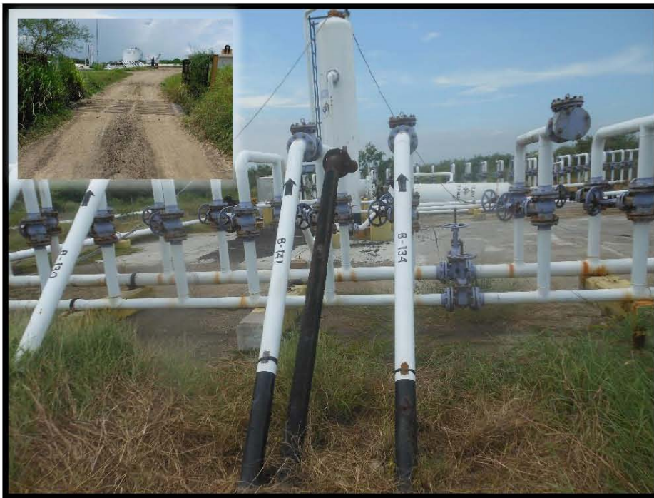
Fotografía 5.- Llegada de Línea de Recolección del Pozo Barcodón 134 a Cabezal de Recolección de la Batería de Separación Barcodón 1, en las coordenadas UTM WGS84 X: 606078 Y: 2497170.
