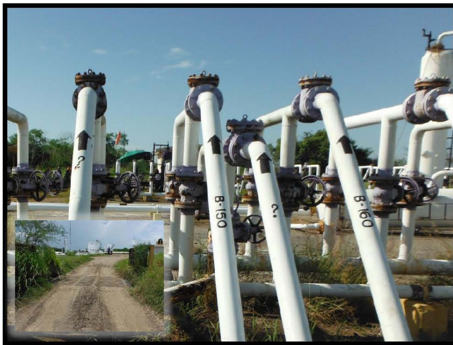
Fotografía 10.- Llegada de Línea de Recolección del Pozo Barcodón 150 a Cabezal de Recolección de Batería de Separación Barcodón 1, en las coordenadas UTMWGS84 X: 606074 Y: 2497157.
