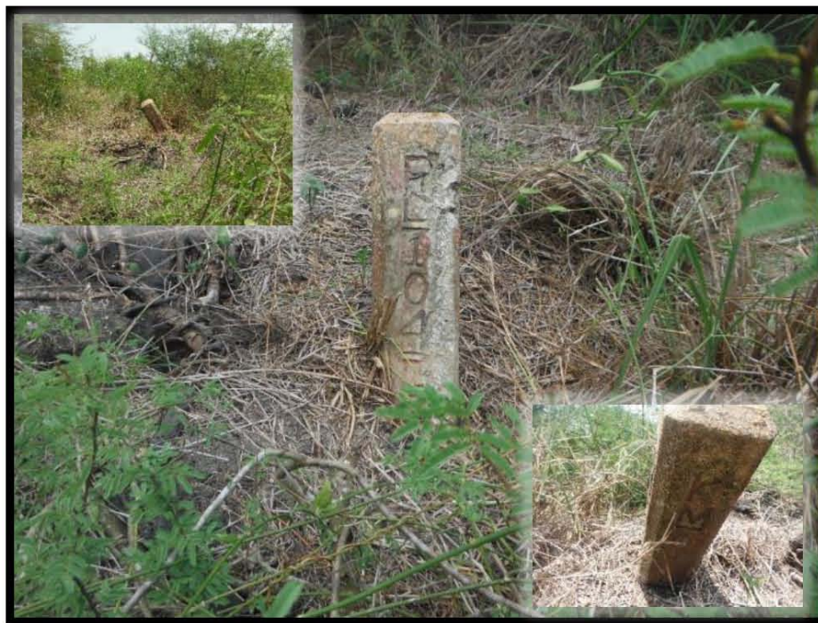
Fotografía 8.- Poste tipo Catódico dañado sin datos sobre Línea De Recolección del Pozo Barcodón 165, en las coordenadas UTM WGS84 X: 605914 Y: 2496851.
