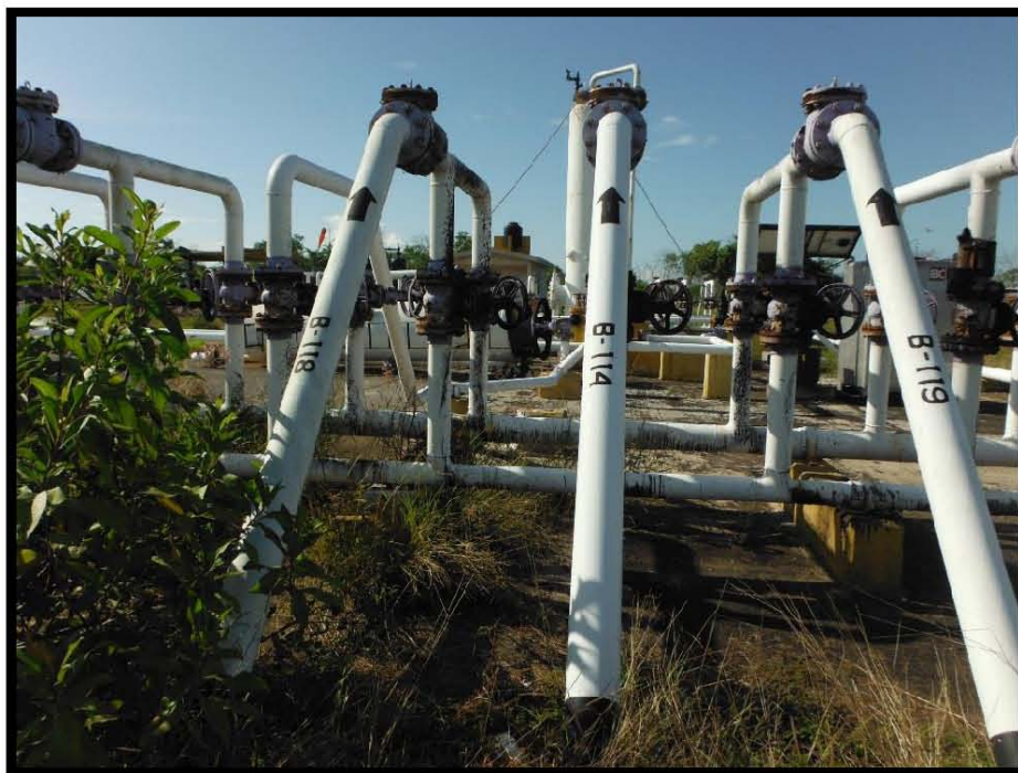
Fotografía 8.- Llegada de Línea de Recolección del Pozo Barcodón 114 a Cabezal de Colector de Batería de Separación Barcodón 1, en las coordenadas UTM WGS84 X: 606078 Y: 2497166.
