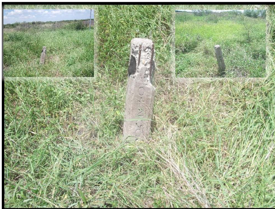
Fotografía 5.- Poste tipo R Km 0+200 dañado del derecho de vía del Pozo Barcodón 138 en las coordenadas UTM WGS84 X: 607103 Y: 2498508.
