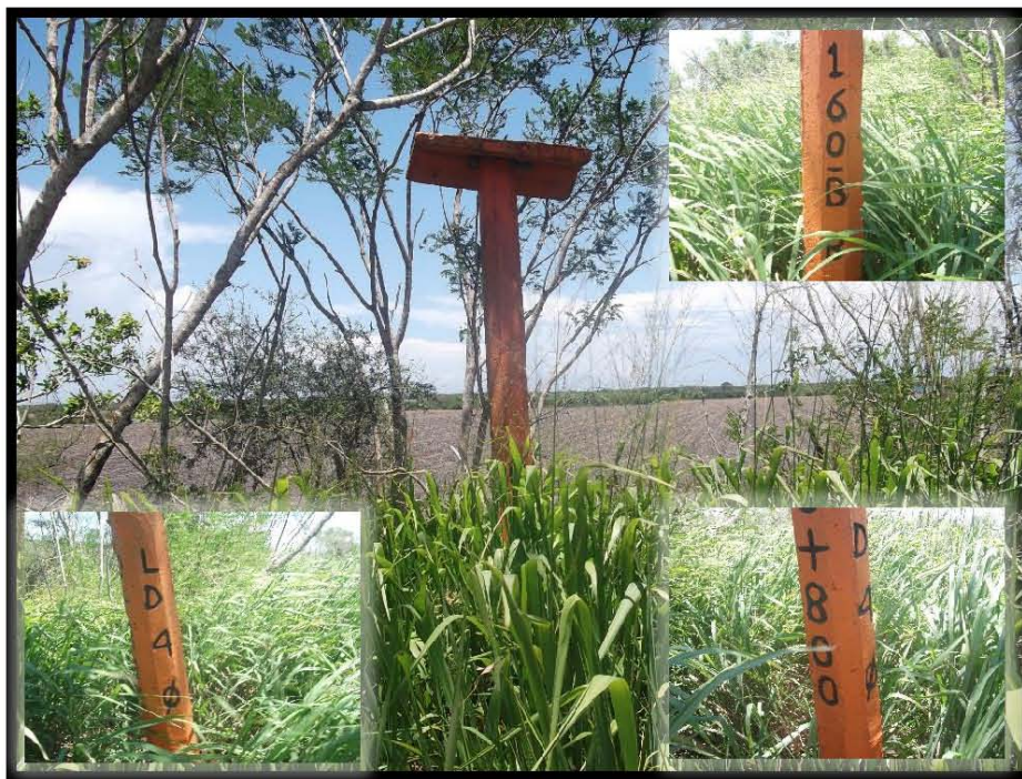
Fotografía 10.- Poste tipo R Barcodón 160, Kilometraje 0+800 con Línea de Descarga de 4", en las coordenadas UTM WGS84 X: 606637 Y: 2497955.
