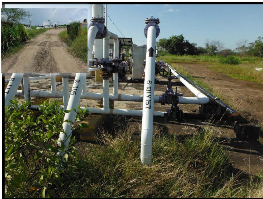
Fotografía 7.- Llegada al Colector de la Línea de Recolección del Pozo Barcodón 116 a la Batería de Separación Barcodón 1, en las coordenadas UTM WGS84 X: 606078 Y: 2497170.
