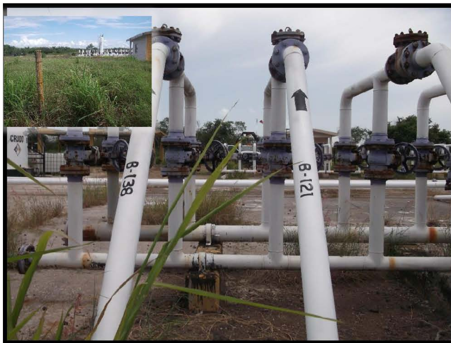
Fotografía 27.- Llegada al Colector de la Línea de Recolección del Pozo Barcodón 138 a la Batería de Separación Barcodón 1 en las coordenadas UTM WGS84 X: 606078 Y: 2497170.
