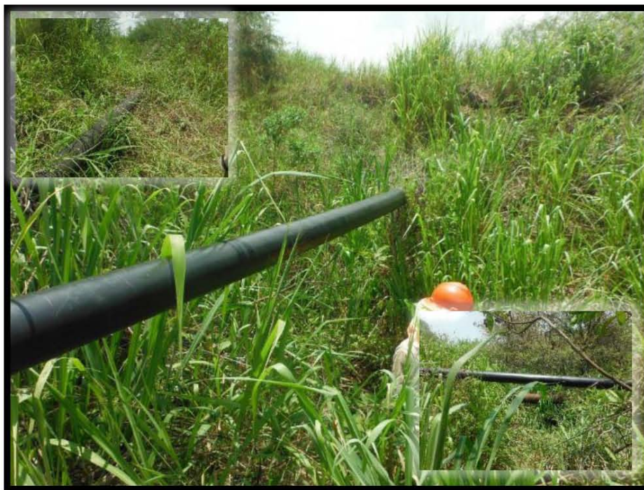
Fotografía 6.- Tubería expuesta sobre Línea De Recolección del Pozo Barcodón 165, en las coordenadas UTM WGS84 X: 605913 Y: 2496540.
