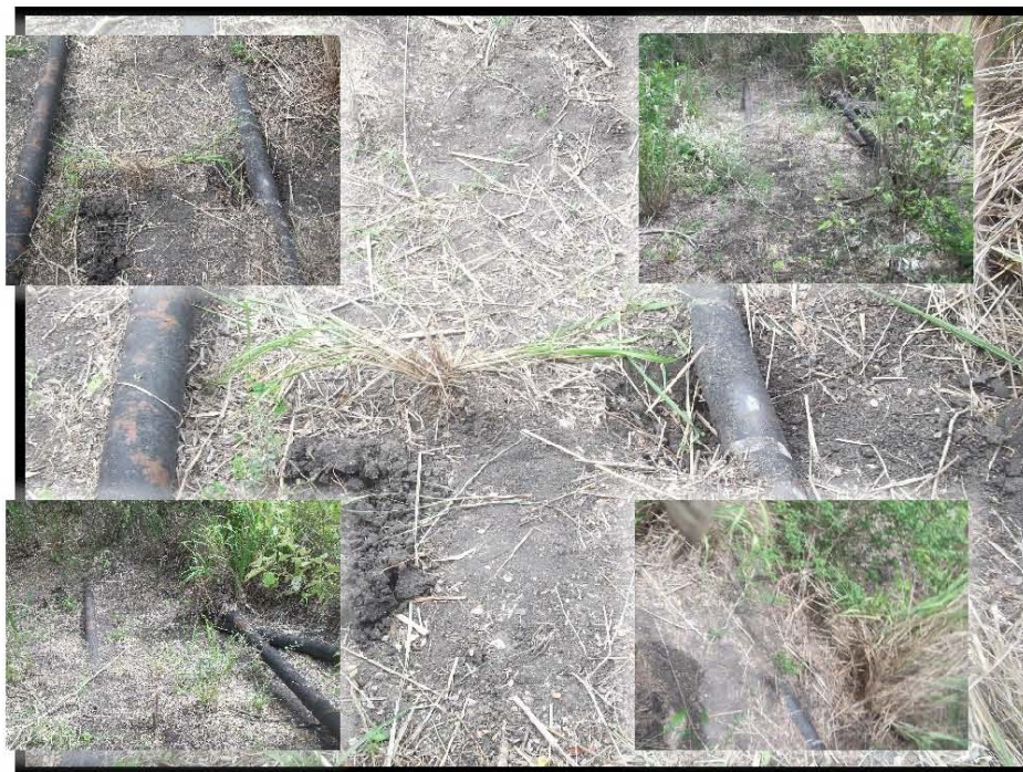
Fotografía 2.- Tubería expuesta de Línea de Recolección del Pozo Barcodón 121, en las coordenadas UTM WGS84 X: 606202 Y:2497640.
