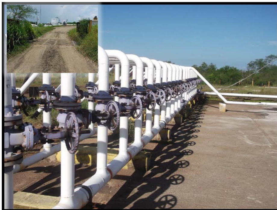
Fotografía 6.- No se Localizó Llegada de Línea de Recolección del Pozo Barcodón 129 a Cabezal de Colectores de Batería de Separación Barcodón 1. En las coordenadas UTM WGS84 X: 606080 Y: 2497138
