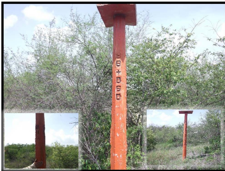
Fotografía 2.- Poste tipo R Barcodón 150, Kilometraje 0+50 con Línea de Descarga de 4", en las coordenadas UTM WGS84 X: 605598 Y: 2495359.
